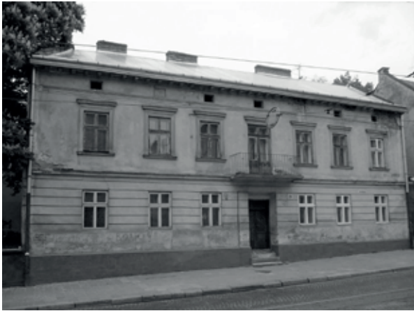
Kamienica przy ul. Łyczakowskiej 23 we Lwowie, którą wybudował i w której zamieszkiwał wraz z rodziną prof. Aleksander Doliński
